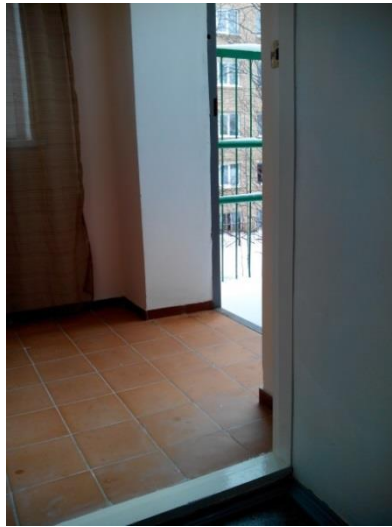
№32 - Эвакуационный выход №4 (запасный - гр. №4)
