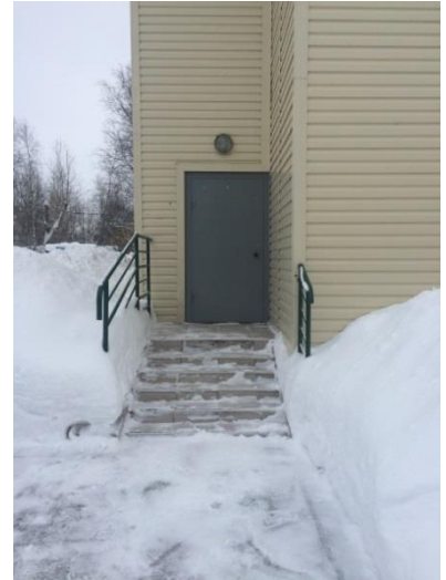
№24 - Эвакуационный выход №1 (запасный - гр. №1)
