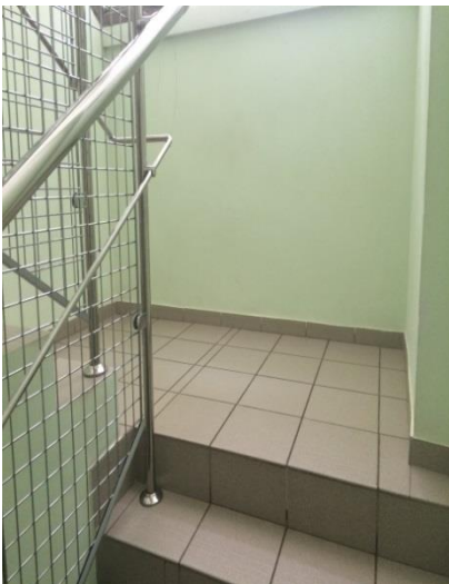
№46 – лестница (внутри здания) (вход №1)
