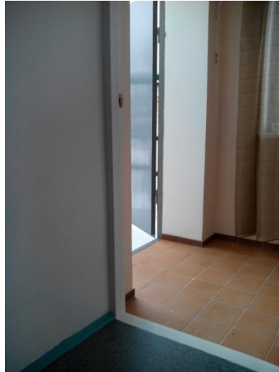
№29 - Эвакуационный выход №3 (запасный - гр. №3)
