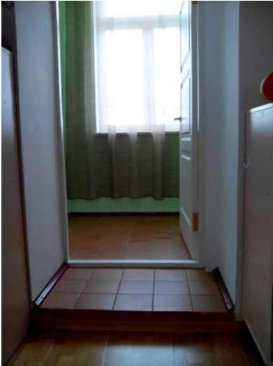
№22 – Эвакуационный выход №1 (запасный - гр. №1)
