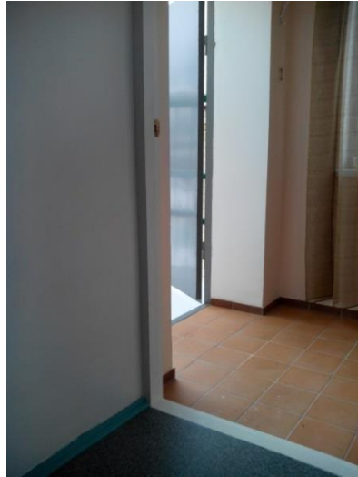
№23 - Эвакуационный выход №1 (запасный - гр. №1)
