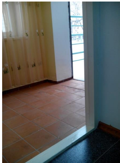
№38 - Эвакуационный выход №6 (запасный - мед. кабинет)
