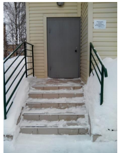
№36 - Эвакуационный выход №5 (запасный - физ. зал)
