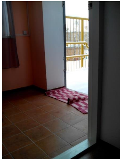
№26 - Эвакуационный выход №2 (запасный - гр.№2)
