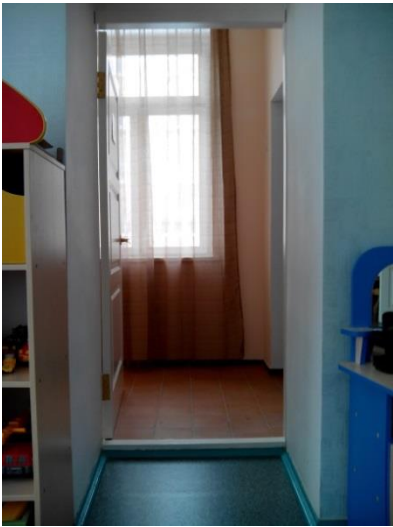
№31 - Эвакуационный выход №4 (запасный - гр. №4)
