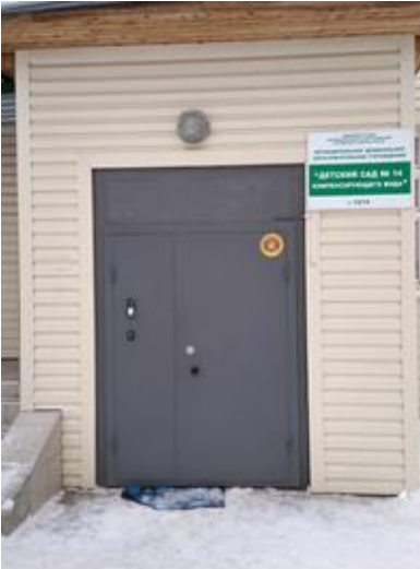
№16 – вход в здание №1 (главный)
