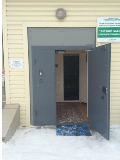
№17 – вход в здание №1 (главный)
