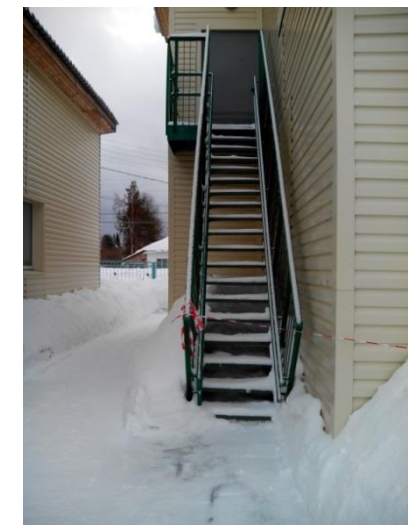
№30 - Эвакуационный выход №3 (запасный - гр. №3)
