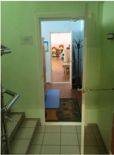
№49 – лестница (внутри здания) (вход в гр. №1)
